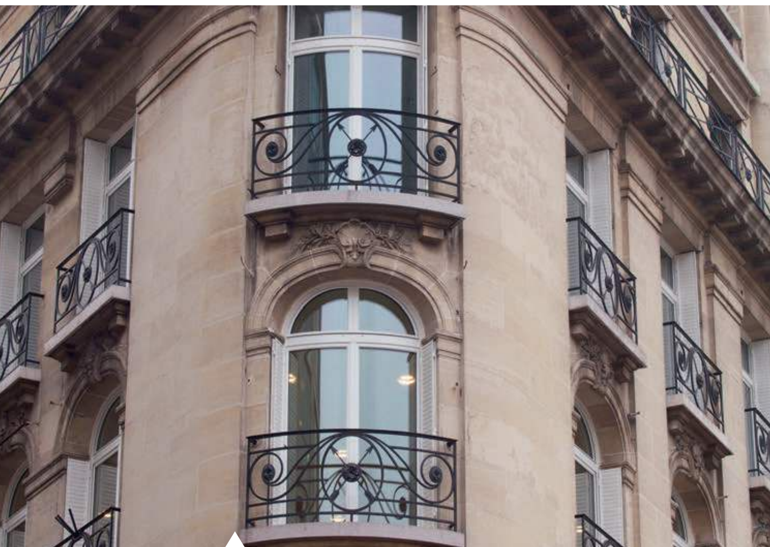
Fenêtres cintrées en plan, Champs Élysées Finition peinture blanche RAL 9016
