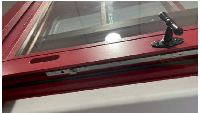
Double joint sous ouvrant pour une meilleure étanchéité en partie basse
