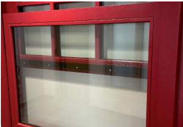
Profils aluminium avec joints intégrés sur la partie centrale pour empêcher le passage d'air
